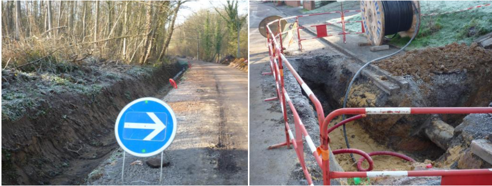
Début des travaux d'enfouissement des réseaux dans la rue du Bois de Rousies
